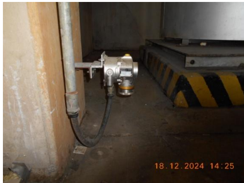
รูปที่ 23 Gas Detector
