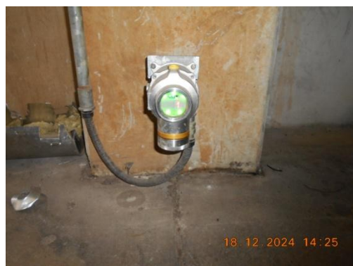
รูปที่ 27 Flammable Gas Detector
