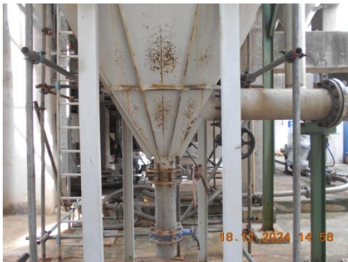
รูปที่ 3 Bag Filter ในระบบดําเลียงเม็ดในลอน
