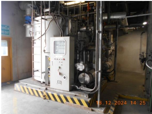
รูปที่ 1 Hot Oil Heater
